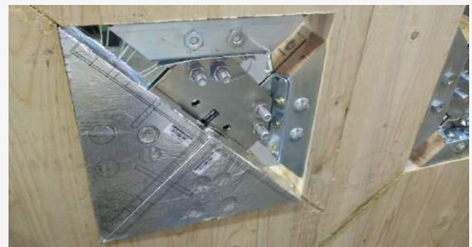
Montage der X-SEAL-Komponenten
