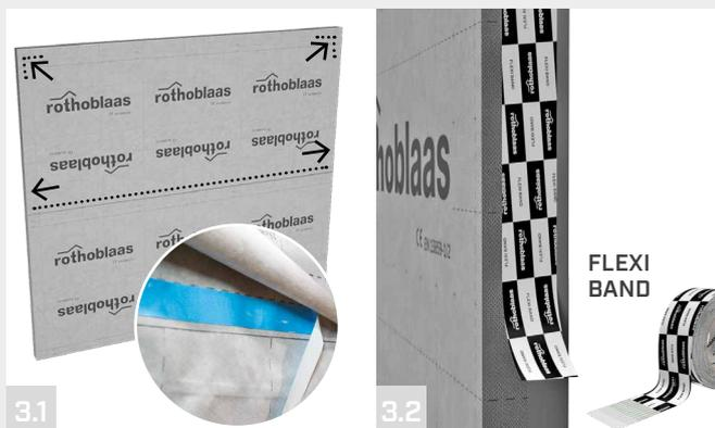
3.1 Marcar el traslape en la zona superior de la membrana inferior. Posteriormente colocar la membrana superior, uniéndola primero con la membrana inferior mediante cinta. Dar tensión tirando, primeramente de la zona superior central, y por último de las esquinas superiores externas. 3.2 Fijar la lámina al perfil con la cinta adhesiva.
