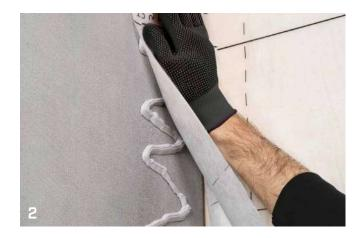
CONNEXION MEMBRANE SUR TOITURE - BÉTON
