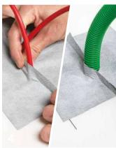
NŒUD FENÊTRE - IMPERMÉABILISATION SOUS CHEVRON
