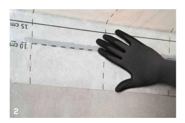
CONNEXION MEMBRANE SUR TOITURE - OSB
