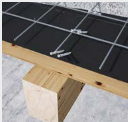
Composiet hout-beton vloer met twee rijen verbindingsmiddelen geplaatst op 30°.
