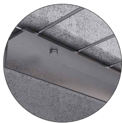
Winkelverbinder aus Stahl 30 x 30 x 3 mm
