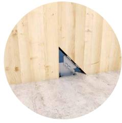
Wenn eine Fundamentbefestigung für nicht tragende Wände oder eine temporäre Befestigung für die korrekte Ausrichtung der Wände (z.B. bei langen Wänden) erforderlich ist, kann an der unteren Ecke der Brettsperrholz-Platte (mit vereinfachtem 45°-Schnitt ohne horizontale Sägen) die BEASYT-Platte (als Alternative zu X-ONE) und an der Fundamentplatte die BEASYC-Platte (als Alternative zu X-PLATE BASE-Platten) angebracht werden.
