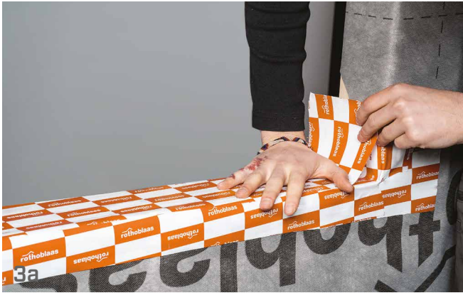
Sellar la ventana con cinta adhesiva Rothoblaas.
