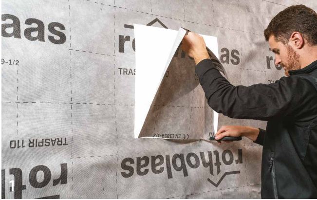
Cortar las aberturas de las ventanas.
