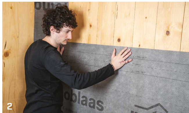
2 Desenrollar la lámina y aplicarla en el panel. Usar un rodillo para mejorar la adhesión al soporte.
